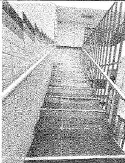
Imagem 07: Detalhe da escada com piso antiderrapante.
