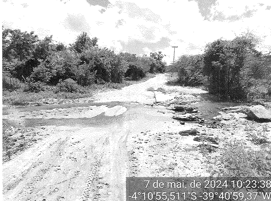
Foto 2 – local onde será construída a obra de travessia de curso d'água.
