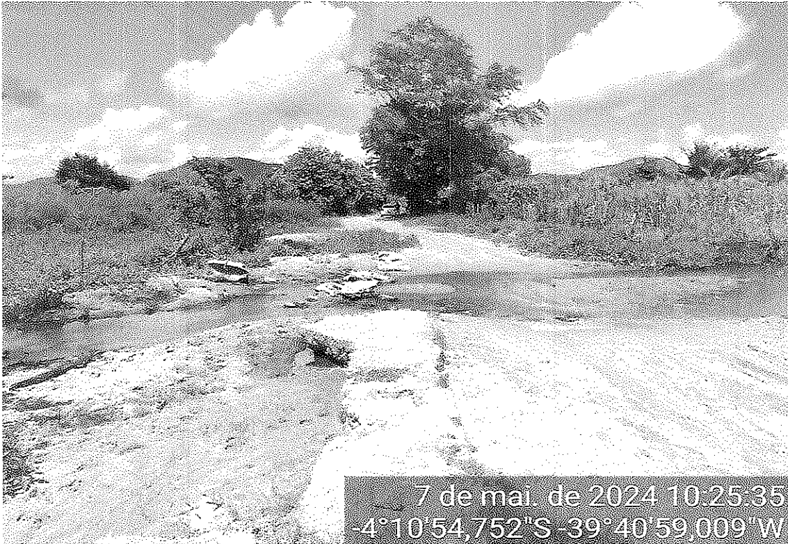
Foto 3: Mais detalhes do local onde será implantada a obra
